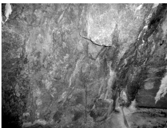
図 5 横坑の一部。隅から地下水がしみだしている。 図 6 横坑を横切る破碎帯。
