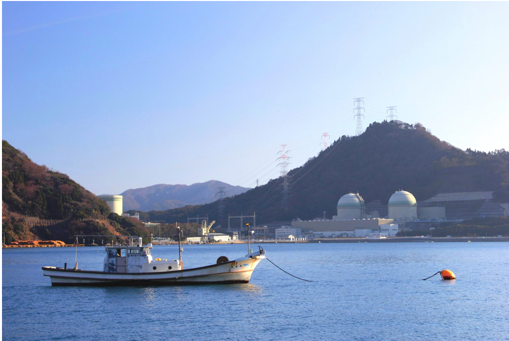
高浜原子力発電所 右側に3号機、4号機が見える
